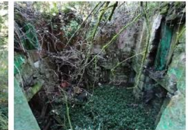
Figura 22 – Interior do Moinho 2 do conjunto de Moinhos de Ponte do Carro
